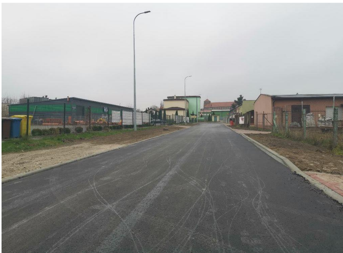
Ulica Budowlana po przebudowie
