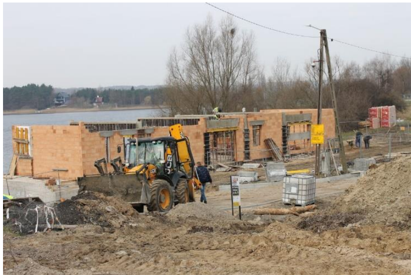
Rewitalizacja Podzamcza - budowa przystani sportów wodnych
