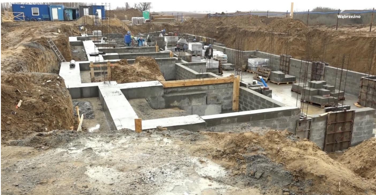
Budowa budynku mieszkalnego na ul. Dantyszka 10
